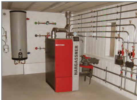
Chaudière EcoHK de 35 kW avec Production d'ECS
