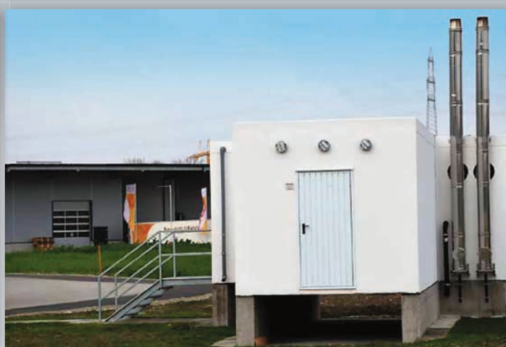
Deux containers simples utilisés comme chaufferie et silo de stockage pour une petite entreprise.
