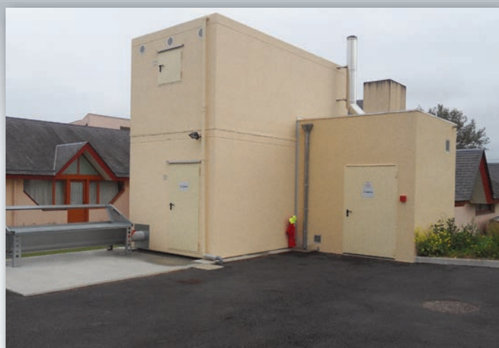
Container double accolé à une salle communale
